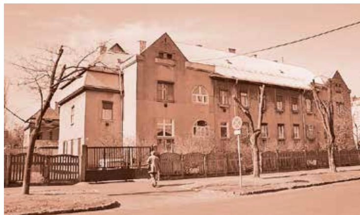
A Rákospalotai MÁV-telep egyik épülete
