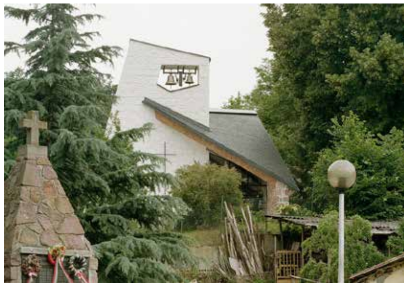
Cserépváralja templom rekonstrukció (Partizan Architecture)
