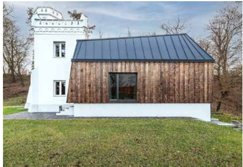
A Malomkert-Bagolyvár újjáépítése (Nanavízió)
