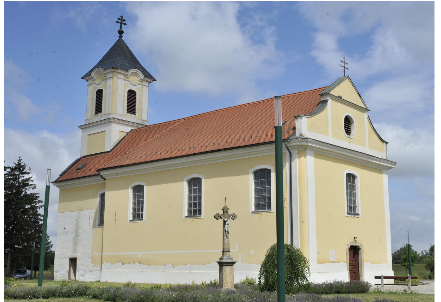
13/1 Az Ipolytölgyesi templom felújítás utáni környezete/The surroundings of the Ipolytölgyes church after renovation
