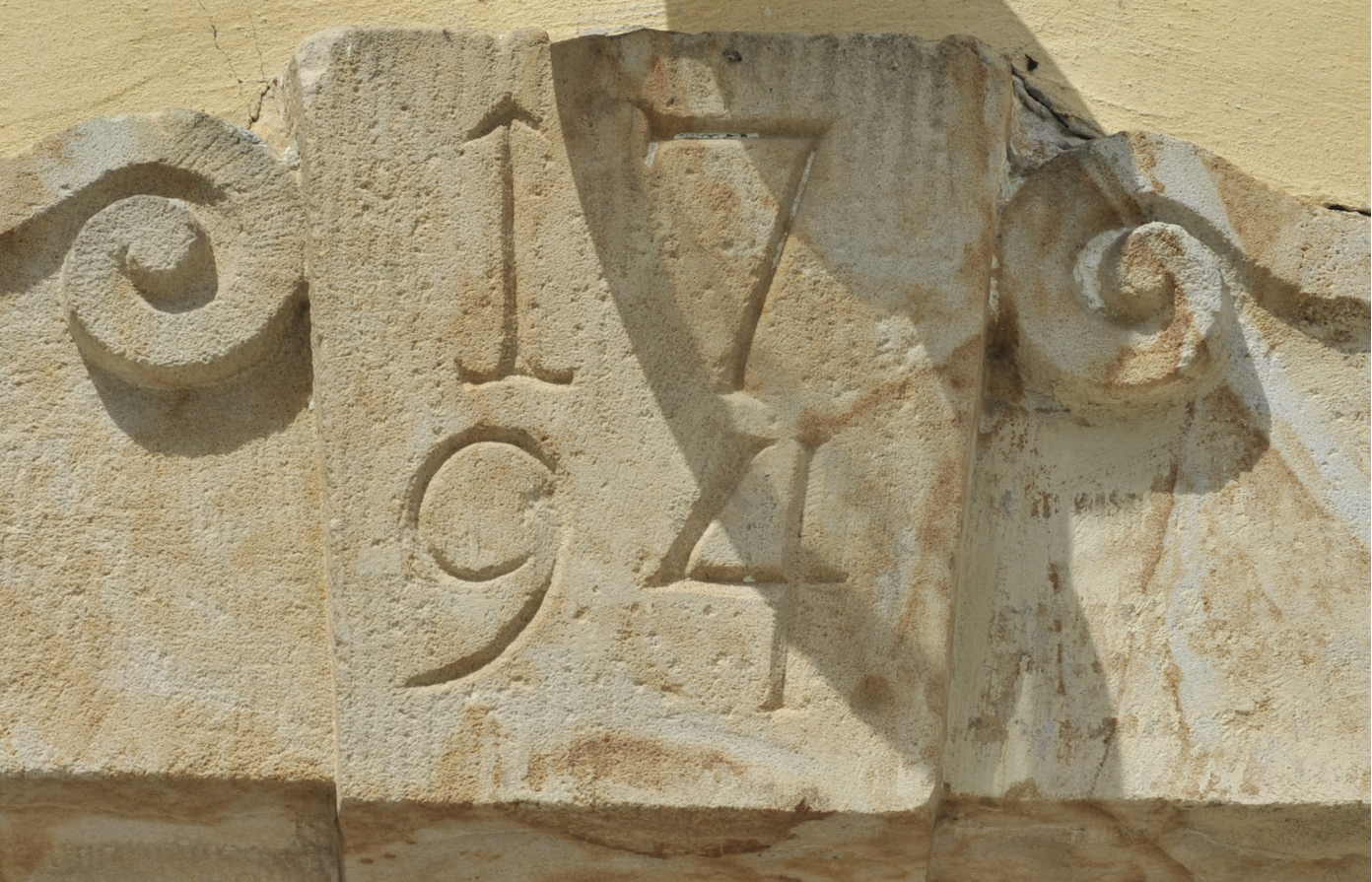
45/1 Kapuzat zárókő / Gate keystone
