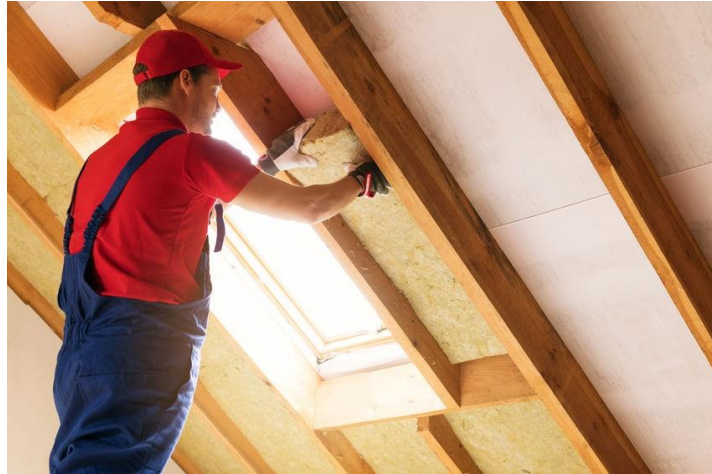
9. ábra Kőzetgyapot tetőtéri hőszigetelés elhelyezése a szarufák közé [ábra forrását lásd később]
