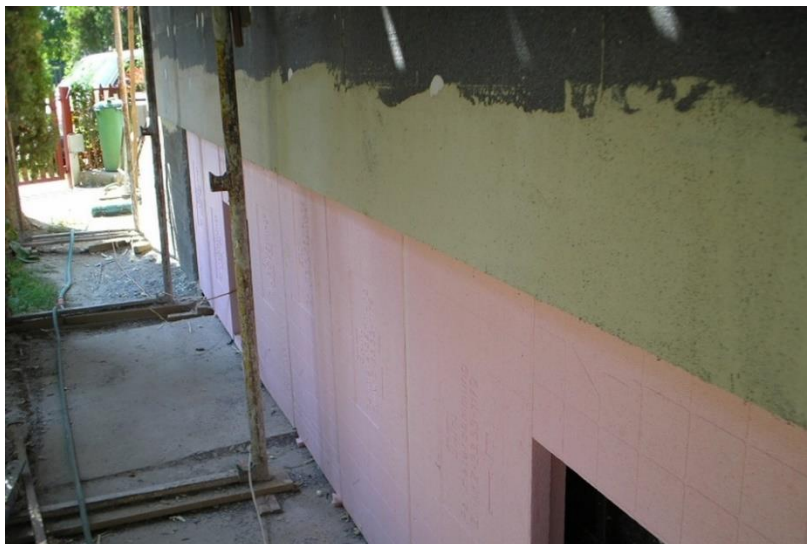
8. ábra Lábazati hőszigetelés Extrudált polisztirolhabbal, azaz XPS-el [ábra forrását lásd később]
