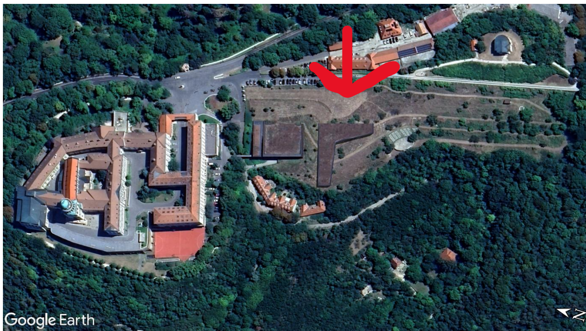
59. ábra: II. telepítési kísérlet: ebben az esetben az egyik fenti skiccen látható módon megtörtem az épület vonalát. Ezáltal az épület jobban tud idomulni a környezethez, továbbá értékes alapterületet nyerhetünk vele, aminek segítségével karcsúbbá is varázsolhatjuk a tömegünket.
