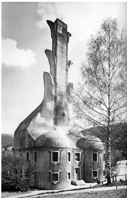
11. ábra A kazánház fotója, 1914. A fotó készítője ismeretlen. Forrás: http://www.rudolfsteinerweb.com/galleries/Other_Buildings/
