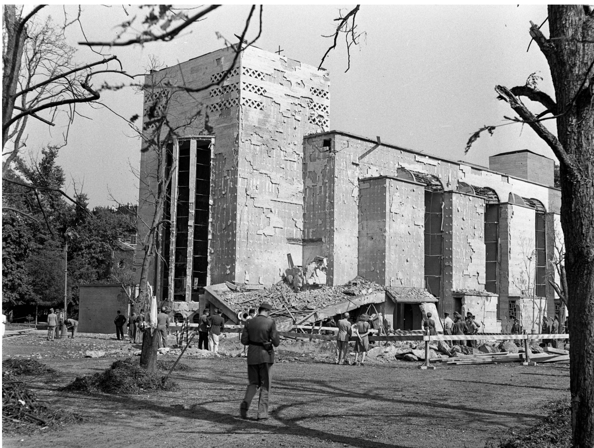
2. kép Jézus-szíve plébániatemplom a bomba becsapódása után 2
